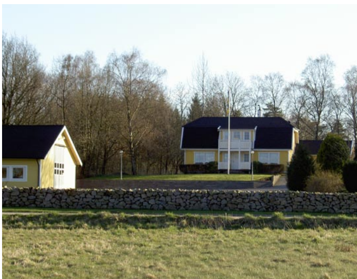
Bild 11. Nybyggd stenmur runt villatomt.
